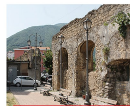
13 Acquedotto di San Renato
